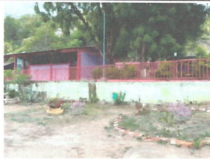
Foto 2: PINTURA EN MUROS INTERIOR Y EXTERIOR
