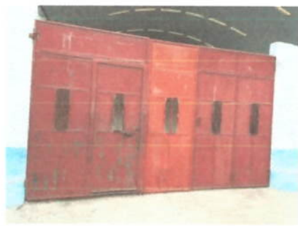
Foto 3: MANTENIMIENTO A PORTON
