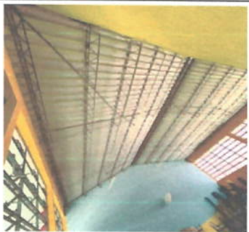
Foto 1: ESTRUCTURA DE TECHO
