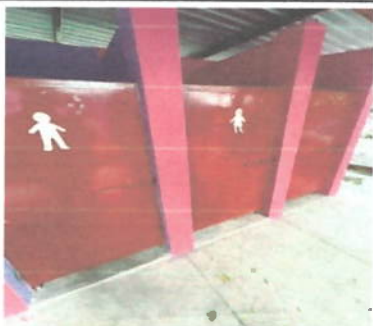
Foto 5: MANTENIMIENTO DE PUERTAS
