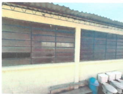
Foto 2: SUSTITUCION DE VENTANAS
