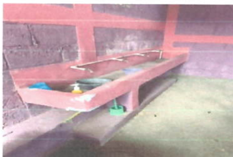
Foto1: SUSTITUCION DE LAVAMANOS
